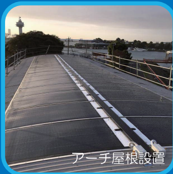
金属屋根設置
